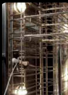
OŚWIETLENIE KOMORY PIECA, SONDA RDZENIA
